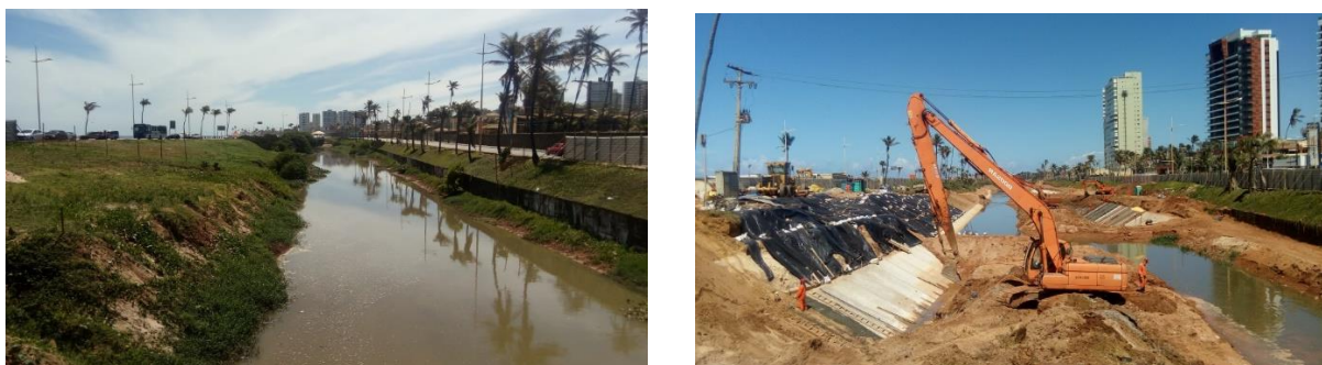
Figura 6 - O antes e o durante as obras de canalização do Rio Jaguaribe - Trecho Orla
